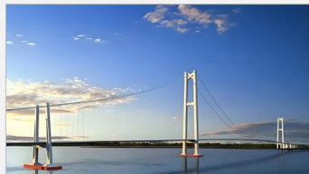
张靖皋大桥跨度2300米
